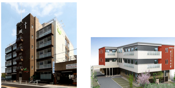
図10. 在宅医療看護介護人材の教育研修施設 聖霊陽明ドクターズタワー(名古屋市昭和区；写真左)とまごころの杜(名古屋市熱田区；写真右)
